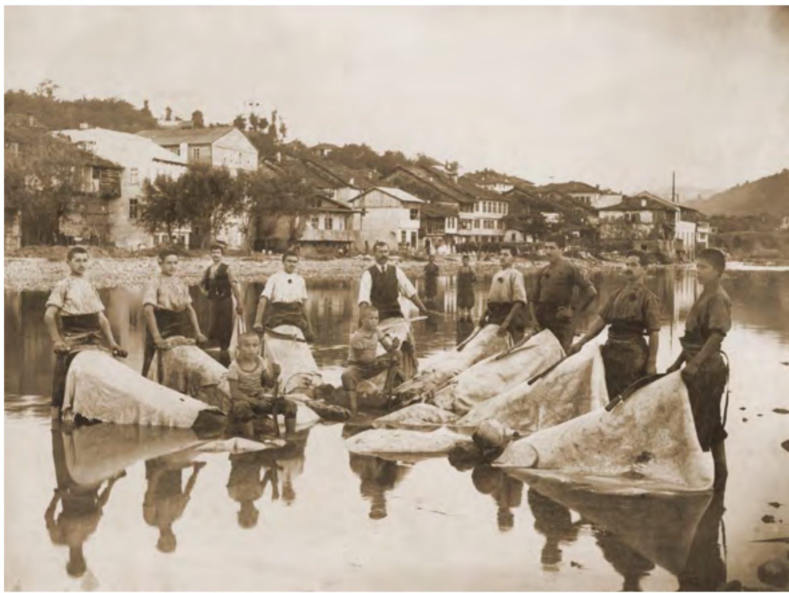
48. Trabajadores del cuero en el río Yantra. Limpieza de las cerdas del cuero con herramientas especializadas. Museo Interactivo de la Industria, Gabrovo, Bulgaria.
